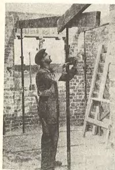
Fig. 43 Nedtagning af dækform med hejsebom.
