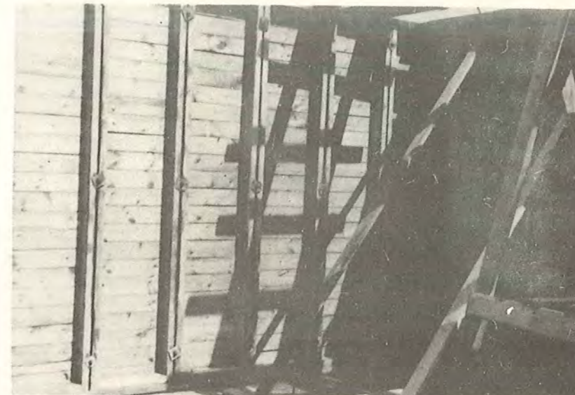
Fig. 70 Brædekassetter beklædt med tynde træfiberplader.
