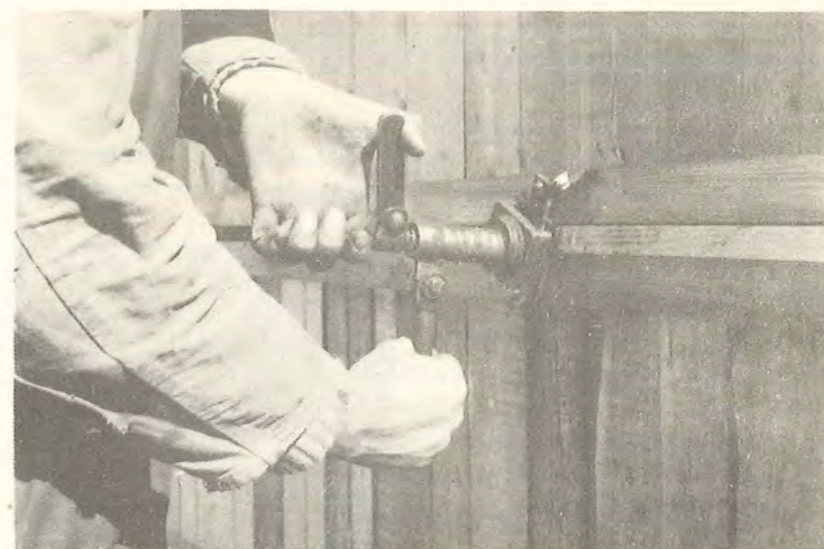
Fig. 80 Værktøj for sammenspænding af vægform (AB BYGMEKANISERING, Malmø).
