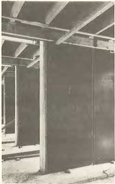
Fig. 82 Formsætning med vægstøtter af beton og 12,5 mm forplader. Spånedebrædderne endnu ikke opsatte.
