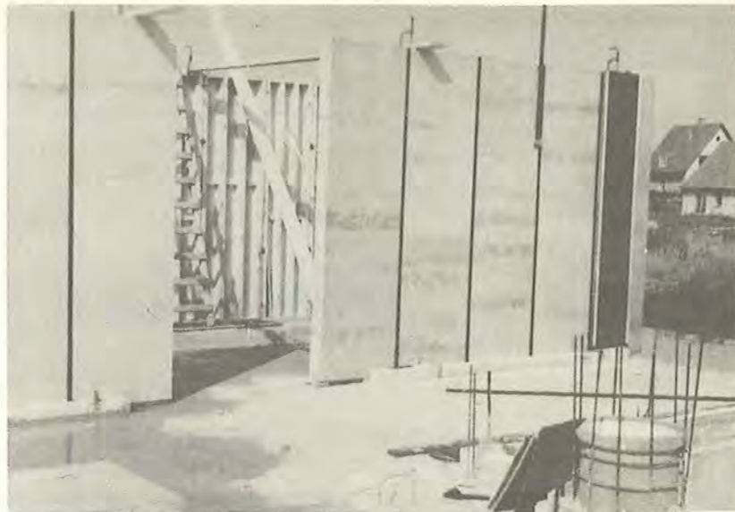
Fig. 83 Formsætning med krydsfinerkassetter, fugejern og "støbt undervæg".
