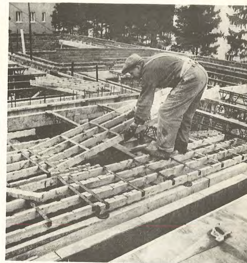
Fig. 42 Raster understøttet af FIX-dragere til dækform.
